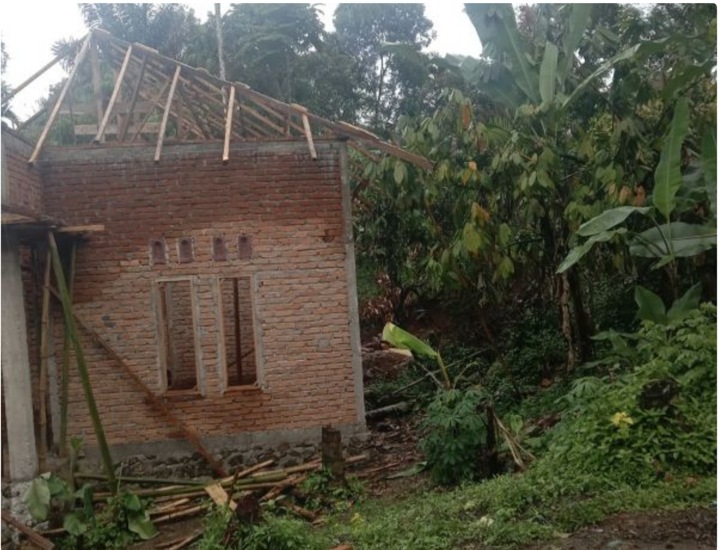
Pembangunan Tanpa Izin Pemilik Lahan
